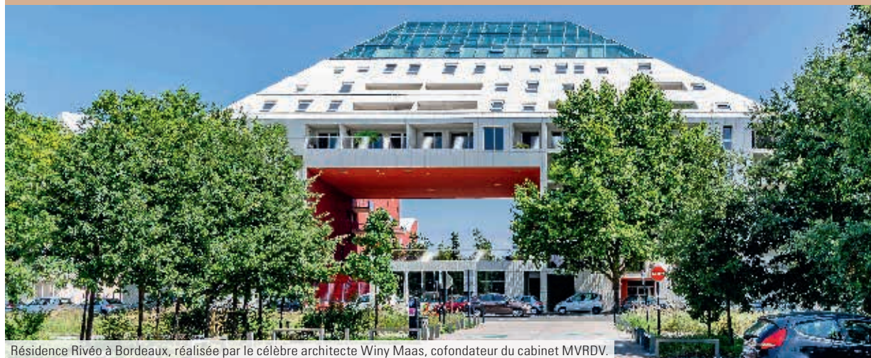
Résidence Rivéo à Bordeaux, réalisée par le célèbre architecte Winy Maas, cofondateur du cabinet MVRDV.
