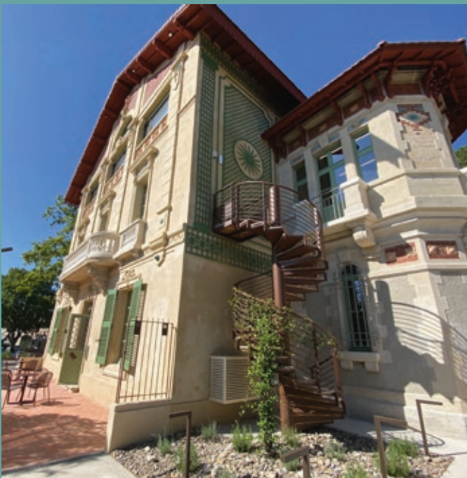
Château des Baumes
